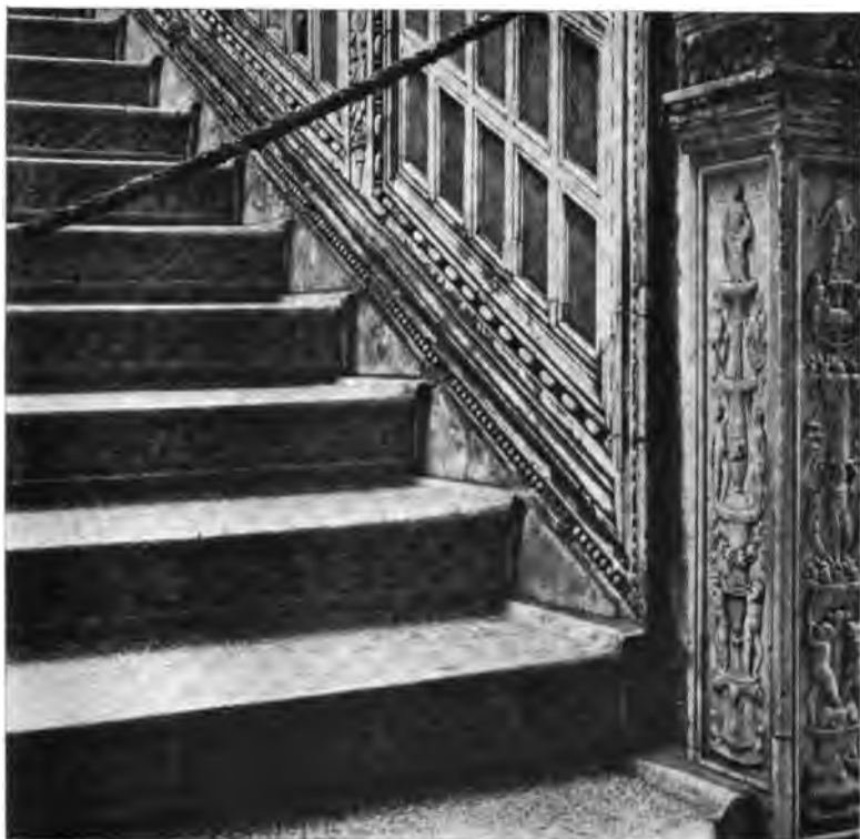
Fig. 98. — Escalier extérieur dit des Géants au Palais Ducal de Venise. Taille des marches pour assurer l'écoulement de l'eau et l'écartier des joints.
